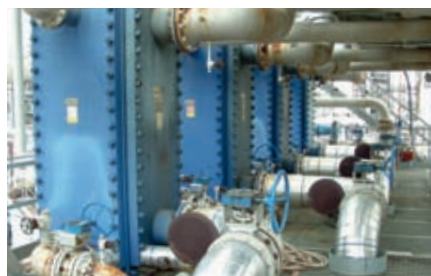
Пластинчатый теплообменник Comtrabloc компании Альфа Лаваль на нефтеперегонном заводе Sarnia в действии
