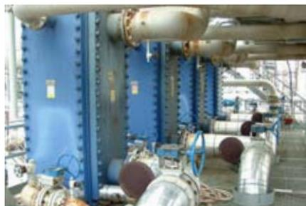
サーニア製油所で使用されているアルファ・ラバルのCompablocプレート式熱交換器。
